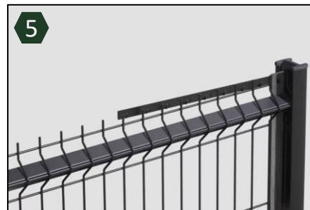
5 Fixez la lame d'extrémité à l'aide de la réglette, au premier ergot
